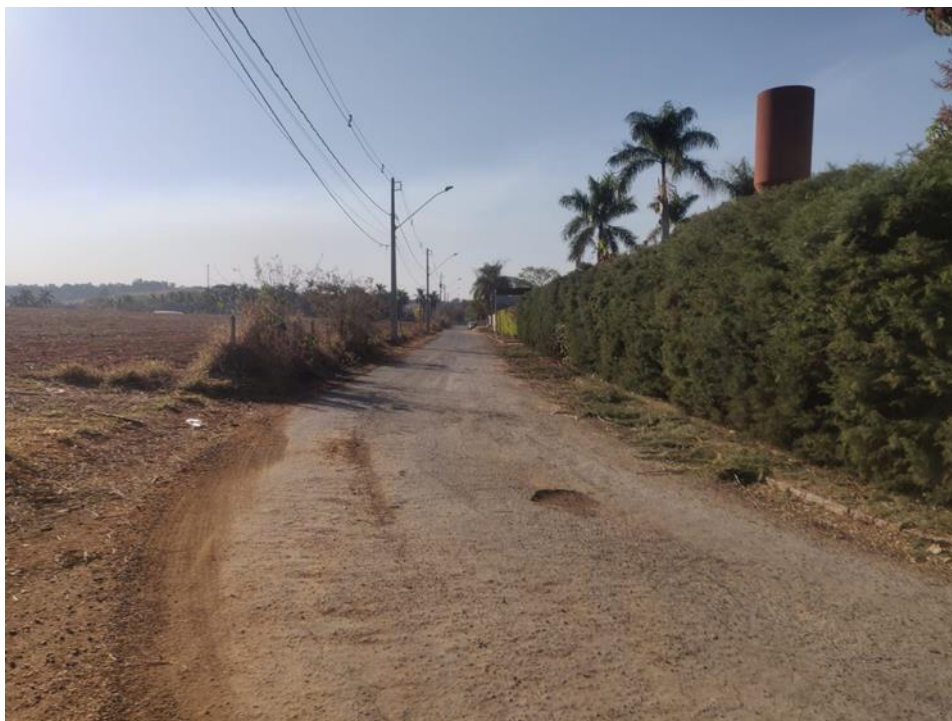
Foto 01: Trecho da Rua Saul Espindola, para execução do calçamento do pavimento intertravado sextavado.
