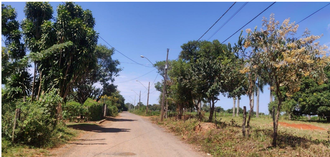
Foto 02: Trecho da Rua Saul Espindola, para execução do calçamento do pavimento intertravado sextavado.
