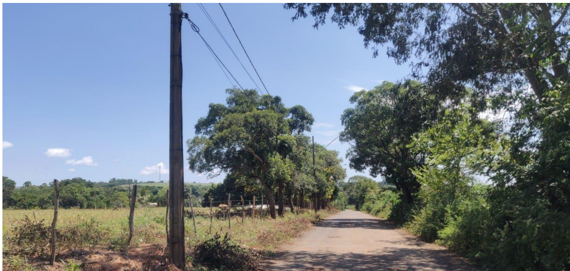
Foto 04: Trecho da Rua Saul Espindola, para execução do calçamento do pavimento intertravado sextavado.
