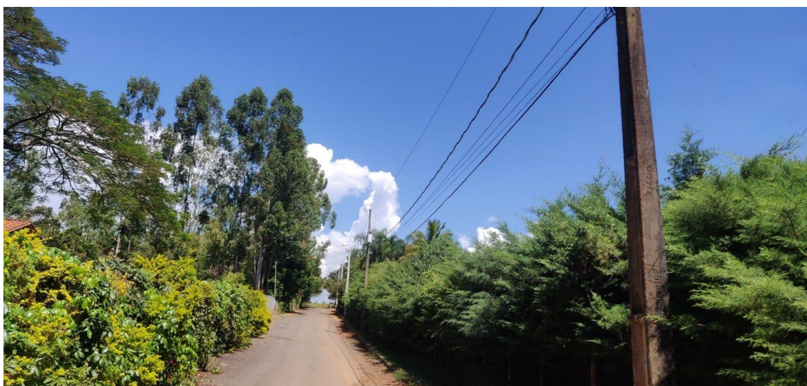
Foto 03: Trecho da Rua Saul Espindola, para execução do calçamento do pavimento intertravado sextavado.
